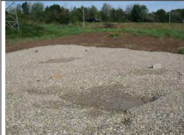
CEF3 Aufschüttung Substrat ( \leq 45 ), Einzelsteine; feuchten Mulden ohne Wasserhaltung
