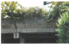
Tiefgarage mit mind. 30 cm Bodenschicht
