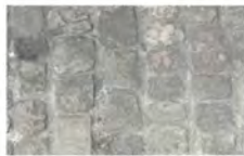
Steinbelag mit Fugenverguss
