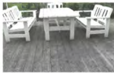
Terrasse, nicht an die Kanalisation angeschlossen
