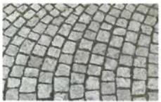
Natursteinpflaster mit offenen Fugen
