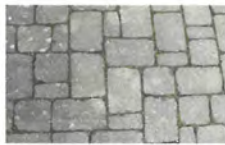
Splittfugenpflaster
