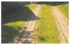
Gepflasterte, nicht an Kanalisation angeschlossene Bodenschicht
