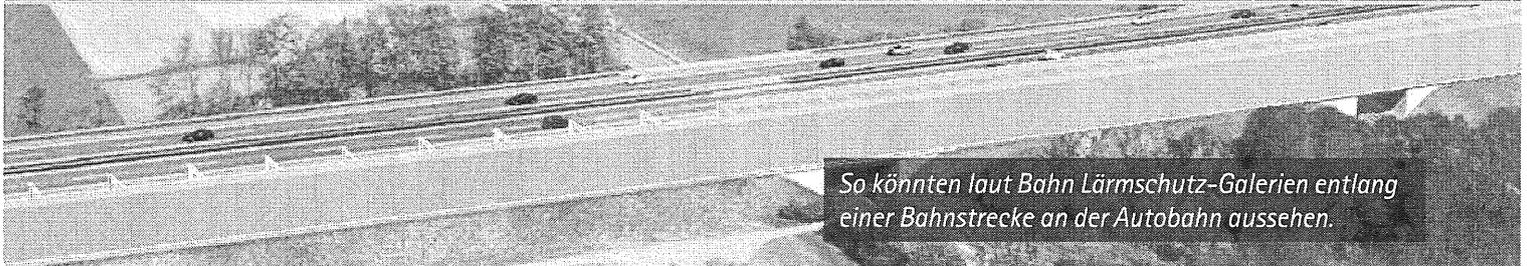
So könnten laut Bahn Lärmschutz-Galerien entlang einer Bahnstrecke an der Autobahn aussehen.
