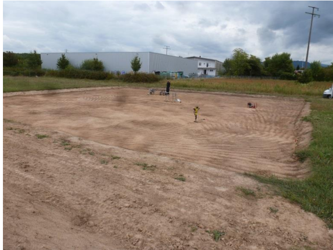
Foto 1: Bereits 40 cm abgeschobenes Baufeld, Blick nach Nord-Osten, aufgenommen am 03.09.2018
