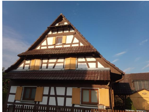
b) Wohnhaus mit Vordachbereichen
